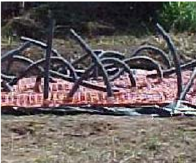
Fig. 1 - Sobre o lençol são lançadas as tubulações de aeração, com espaçamento de aproximadamente 50 centímetros, cobrindo-as com a tela sobreposta em duas camadas, posteriormente ao seu arranjo.
