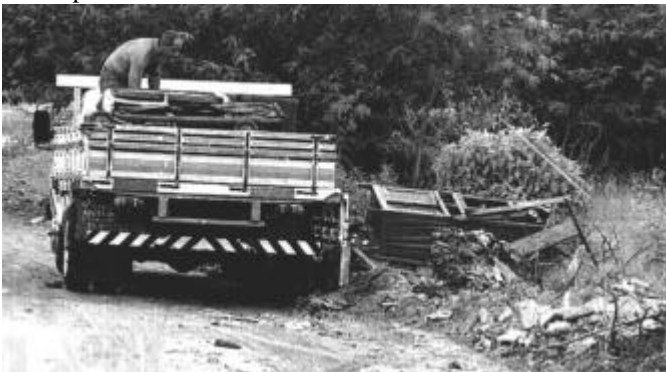
Fig 2 – Lançamento de resíduo de construção e demolição (ENTULHO, 2002) [9].
